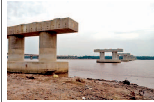
నిర్మాణం మధ్యలో నిలిచిపోయిన రైల్వే బ్రిడ్జి వసులు
